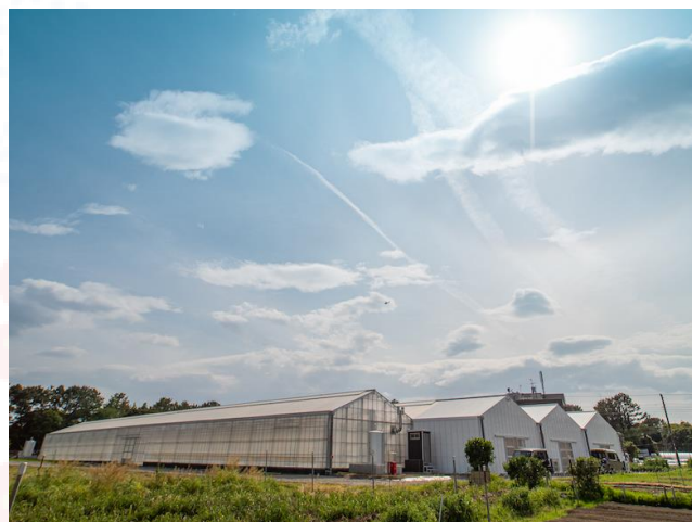
屋根型フィルムハウス 外観
