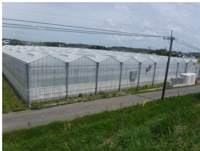
2020年完成 多連棟型ハウス
