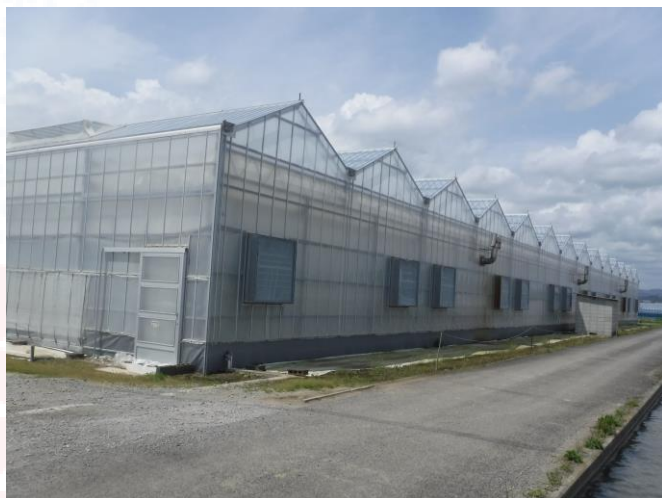
2017年完成 多連棟型ハウス
