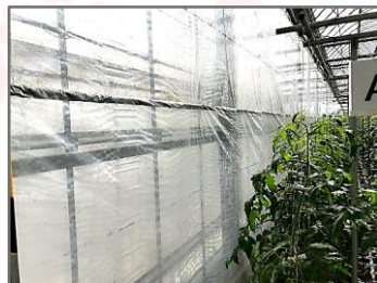
内張りフィルム
